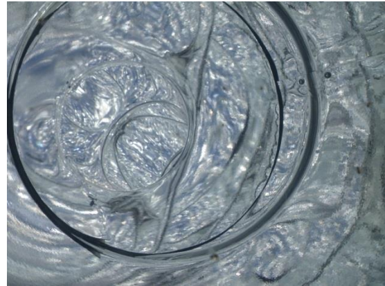
【ダクト内写真】
